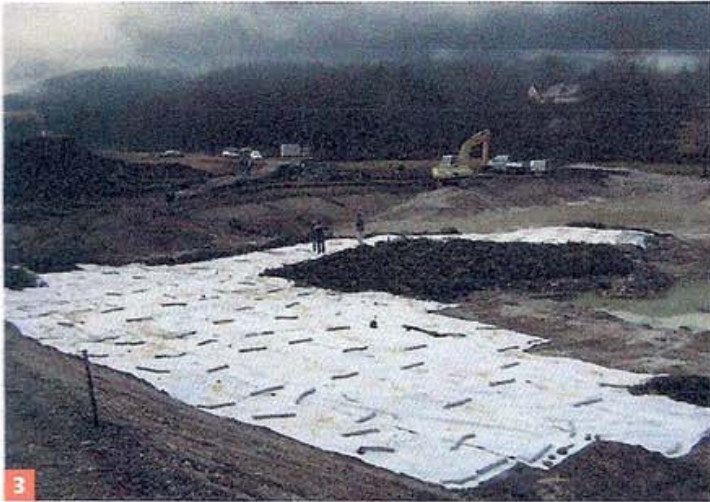
3 Flächensprengung für das Amt der NÖ Landesregierung/Abteilung Flussbau. Hier wurde ein Rückhaltebecken angelegt. Die Sprengung musste ebenfalls mittels spezieller Sprengtechnik durchgeführt werden, da die Bundesstraße, die Freileitung der EVN, ein privates Kraftwerk und ein Gebäude in unmittelbarer Nähe waren 4 Nach glücklicher Flächensprengung
