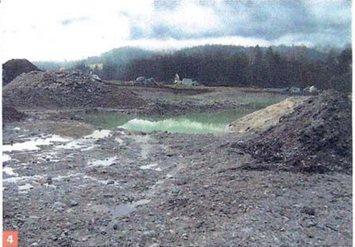
3 Flächensprengung für das Amt der NÖ Landesregierung/Abteilung Flussbau. Hier wurde ein Rückhaltebecken angelegt. Die Sprengung musste ebenfalls mittels spezieller Sprengtechnik durchgeführt werden, da die Bundesstraße, die Freileitung der EVN, ein privates Kraftwerk und ein Gebäude in unmittelbarer Nähe waren 4 Nach glücklicher Flächensprengung
